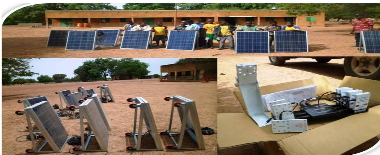
Les caractéristiques électriques sont indiquées à l'arrière du module sur une plaque signalétique inamovible. Le module photovoltaïque a une durée de vie minimum de cinq (05) ans. Pour la garantie d'efficacité, les modules fournissent une puissance égale au moins à 90% de la valeur nominale après 05 ans et au moins 80 % après 10 ans.
